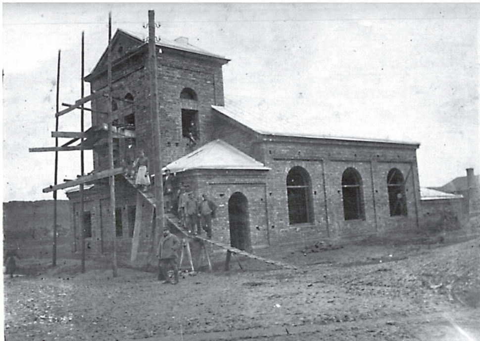
Fot. Ciechanów 1924 r., budowa elektrowni miejskiej
