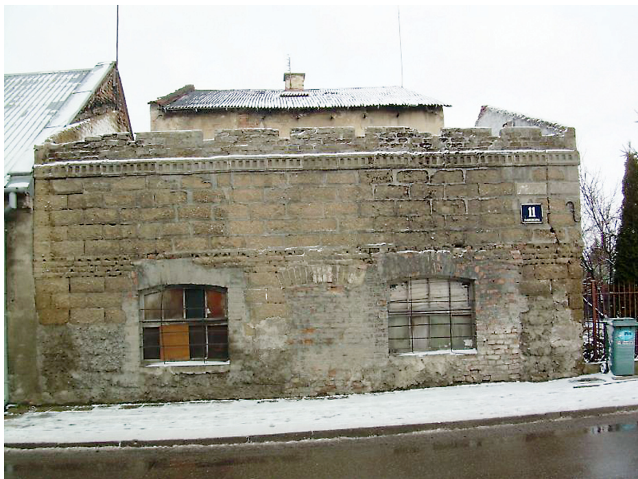
Fot. Budynek przy ul. Nadrzecznej 11. Pozostałości dawnej kaskarni w 2012 r.
