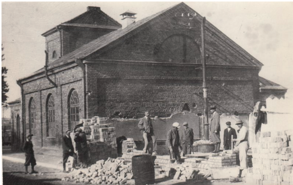
Fot. Rozbudowa elektrowni, 1935–1936 r.
